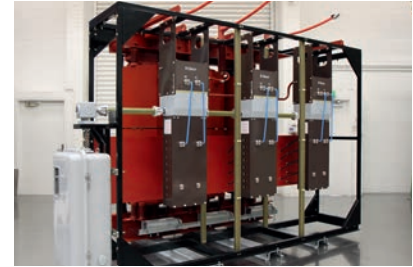
Umsteller (schaltbar unter Last)
