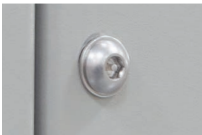
Sicherungsschrauben für abnehmbare Bleche
